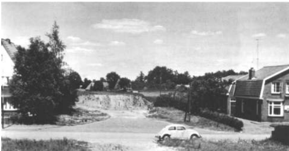
>• Het talud voor het viaduct over de Buurserstraat. (Archiefphoto HKH)
